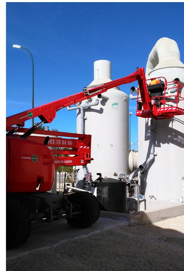
Trabajos de altura con grúa elevadora
