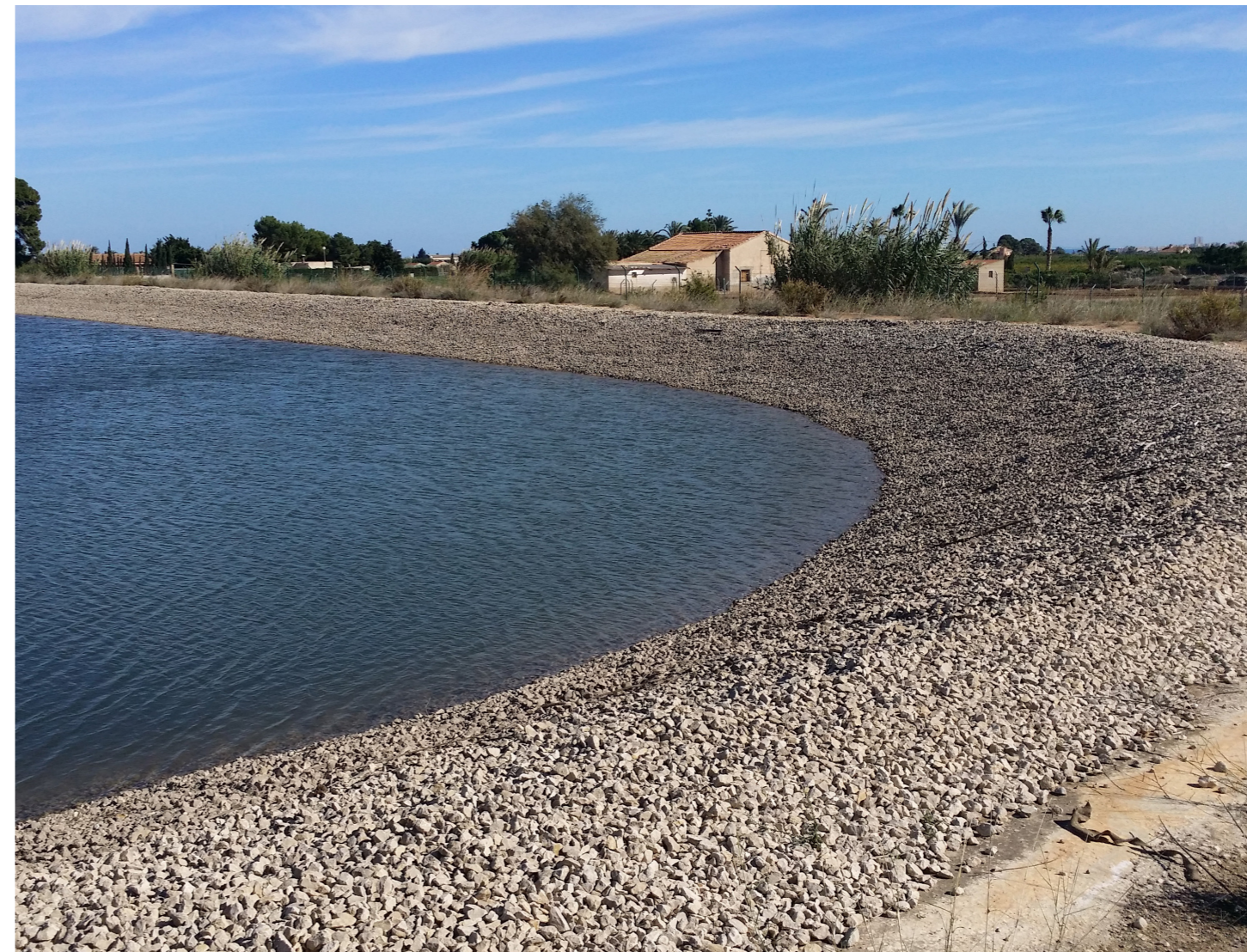
Depósito tormentas Torrellano
