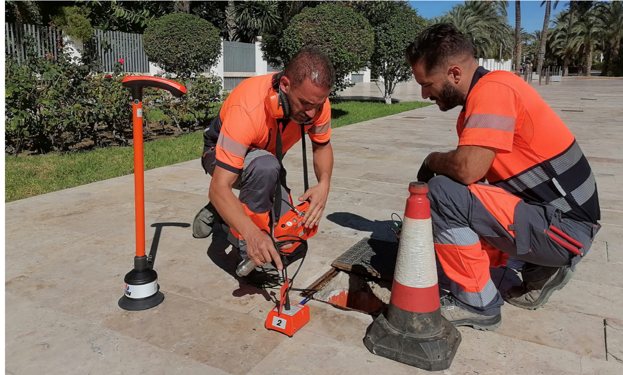
Trabajos búsqueda de fugas
