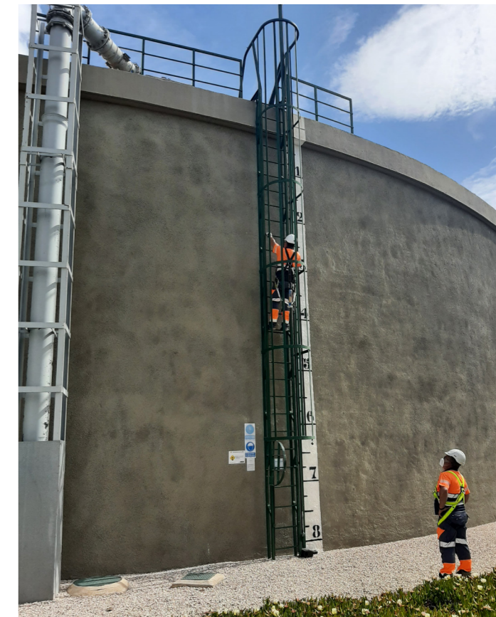
Inspección del estado de los depósitos
