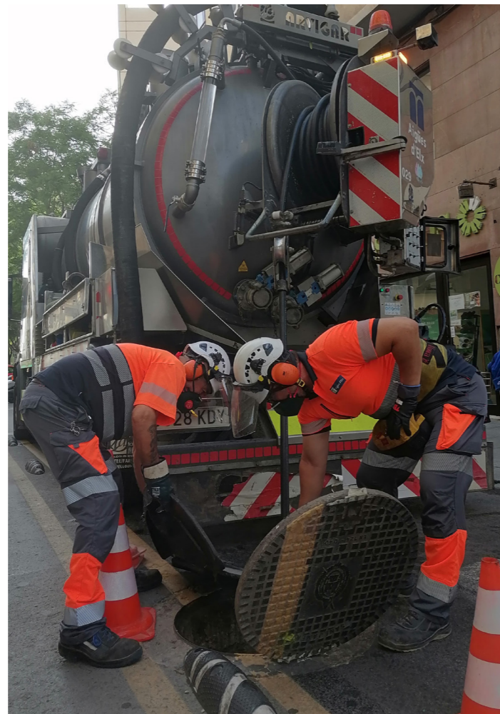
Trabajos en red de alcantarillado
