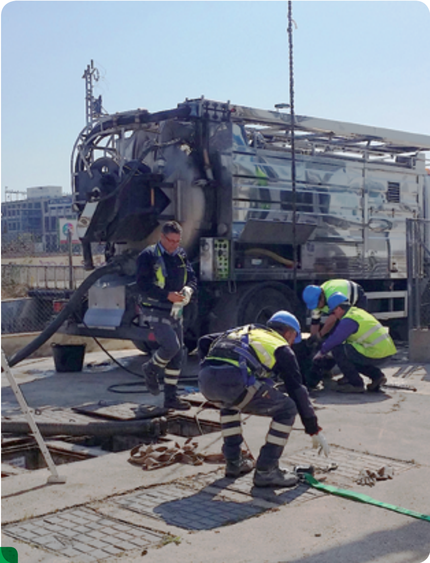
Mantenimiento bombeo de alcantarillado
