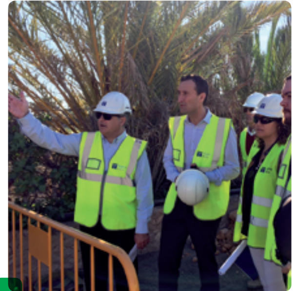
Visita a pie de obra del inicio de la primera fase del colector de Peña las Águilas y Llano San José
