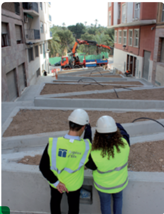
Construcción de xerojardín y rampas de acceso en zigzag en la calle Hermanos González Selva
