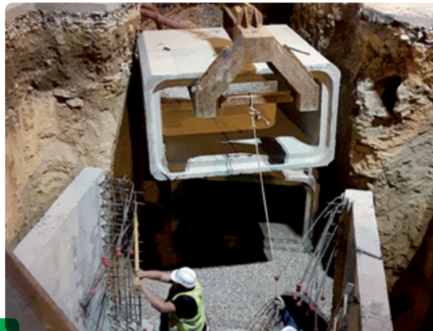
Instalación de arqueta prefabricada
