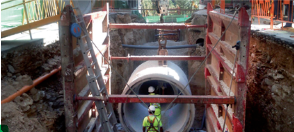
Obras del colector de pluviales
