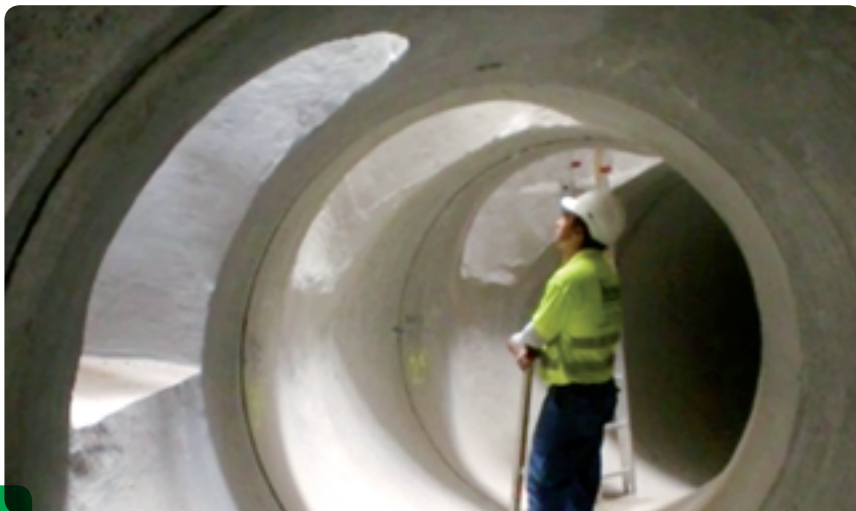
Operario en el interior del colector de pluviales
